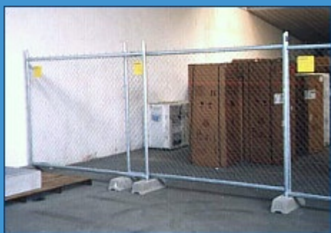
Prispôsobenie dĺžky oplotenia presadením rámov v prípade horizontálnej prekážky. Rámy sú spojené zaist'ovacou sponou upnutou na ich horizontálne profily.
